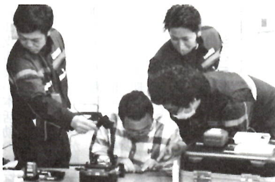
記者に光ケーブルの融着作業の説明（八重山センタ）
